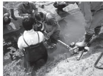
魚道の設置状況（堰板の設置）
