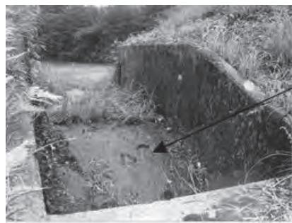
洪水吐底板（コンクリート）の欠損
