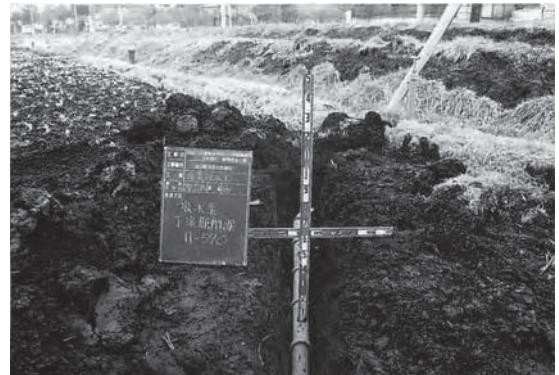
吸水渠（素焼土管）設置状況
