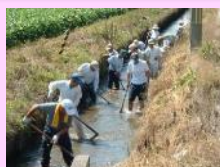
水路の泥上げ
