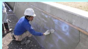
老朽化した水路壁のコーティング
