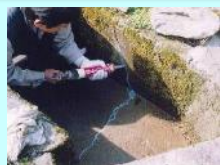
水路のひび割れ補修
