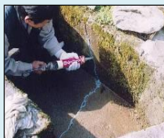
ひび割れの補修
