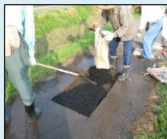
農道の部分補修
