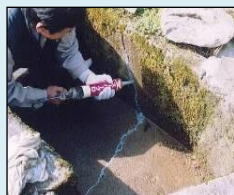
ひび割れの補修
