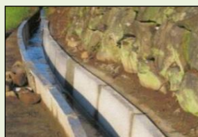
素堀り水路からの更新
