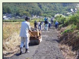
未舗装農道の舗装
