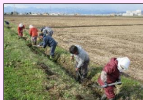
水路の泥上げ
