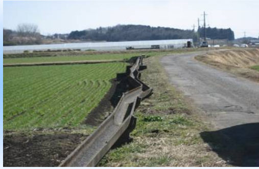
地震により受台から落下した水路
