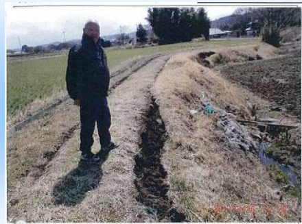
地震による農道法面の崩落
