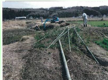
法面崩落箇所掘削
