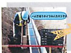
【水路の両側同時に埋戻しをおこなう締固めをします。埋戻し、締固めを数回繰り返します】
