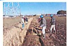
【水路法線の確認】
