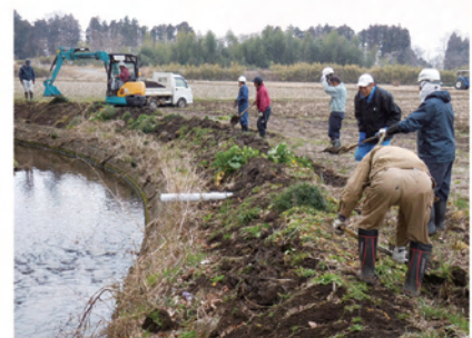
復旧した排水路法面
