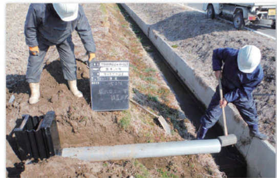
田んぼダムを設置中
