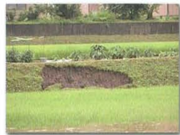
農用地法面の崩壊
