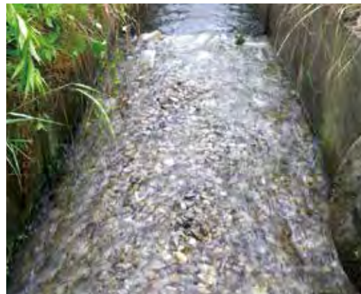
間詰めに碎石を投入して完成。
