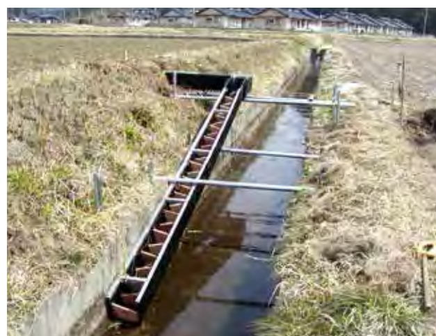
単管パイプで施設上部を固定、下部も浮き上がらないように固定。
