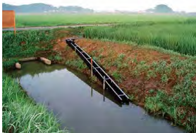
水路法面に埋設して固定する。
