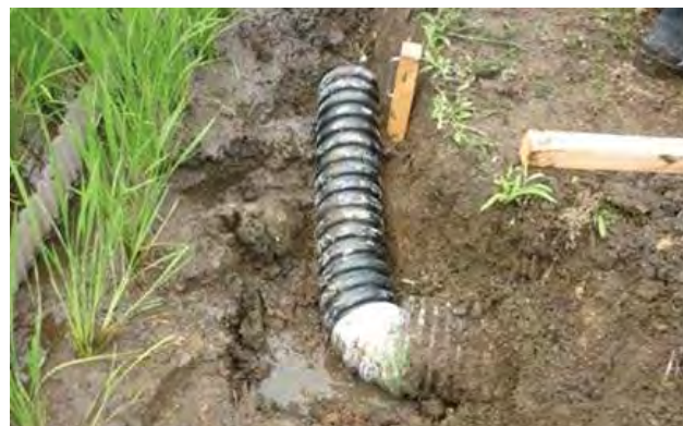
曲がりやすい素材の管をつなぎ、杭に水口をひっかけて高さ を調整するタイプ。
