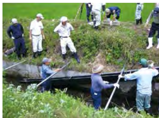
鉄パイプで魚道の勾配や高さを調整して…。
