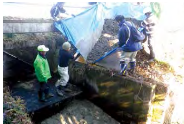
自主施工で生コンクリートを打設。
