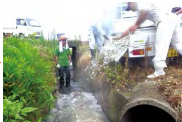
碎石を投入して安定させます。
