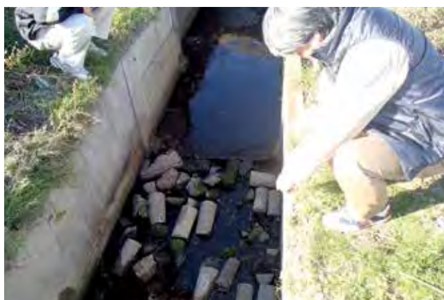
設置後の状況(およそ1年程経過)。
