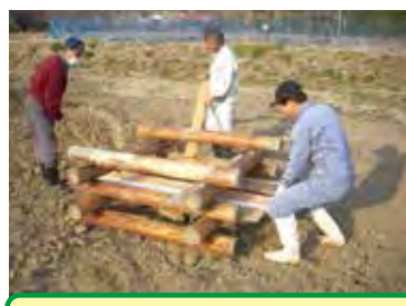
生きものの隠れ場「井桁沈床」 いげたちんしょう
