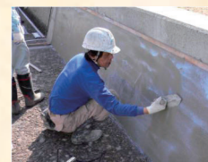
水路壁のコーティング
