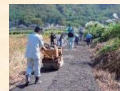
未舗装農道の舗装
