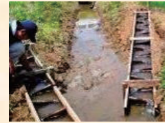
水田魚道の設置
