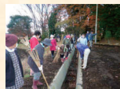
水路の泥上げ
