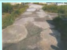
農道の窪みの補修
