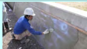
老朽化した水路壁のコーティング
