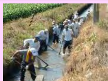
水路の泥上げ
