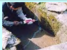
水路のひび割れ補修
