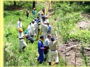
獣害防護柵の設置
