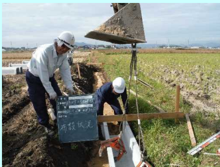
【コンクリート水路への改修】
