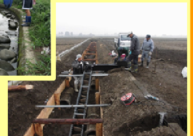
【魚道設置工事】
