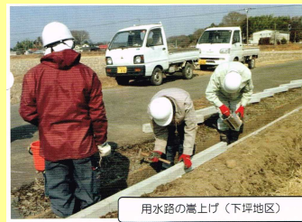
用水路の嵩上げ（下坪地区）
