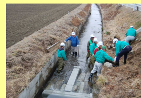
生きものに優しい施設 (U字溝で魚の隠れ家)
