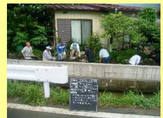
水路整備(嵩上げ)
