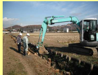
土水路法面の土留
