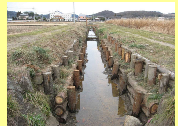
施工後土水路
