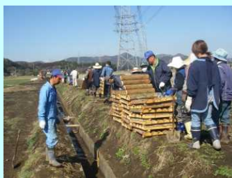
水路の蓋掛け(カエル蓋)
