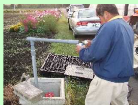
【パイプライン補修】
