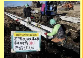
【直営施工の様子】
