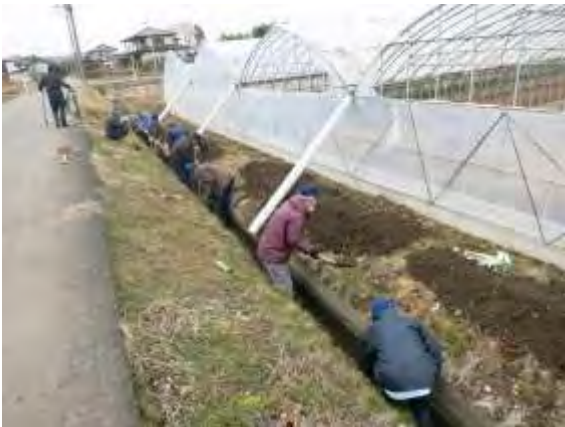
水路の泥上げ作業
