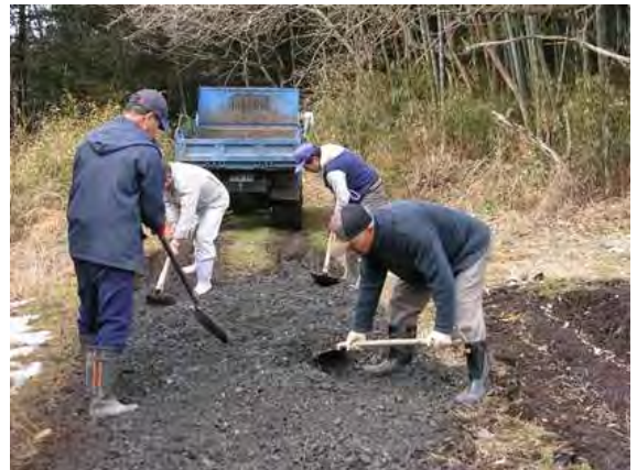
農道補修(砂利敷き)
