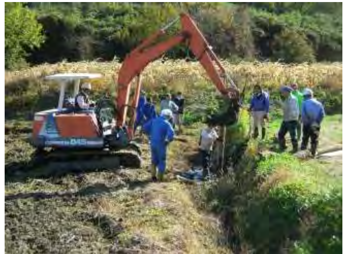
直営による水路補修
