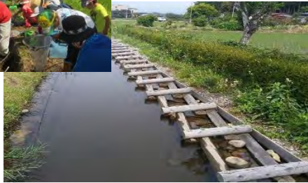
環境配慮型水路
