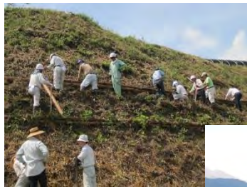
小段の設置風景
