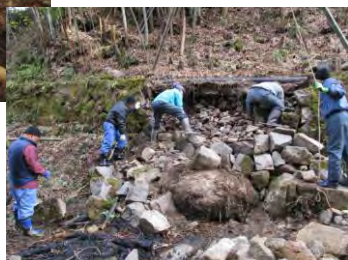
石積水路の補修
