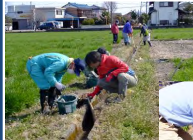
水路の補修風景
