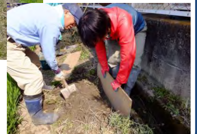
水路の補修風景
