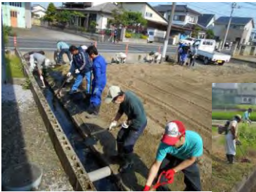
水路の清掃作業
