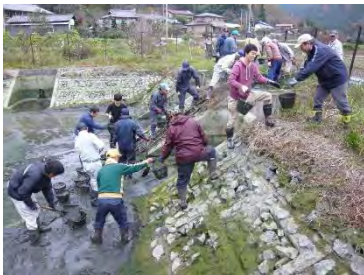
調整池の汚泥の除去作業
