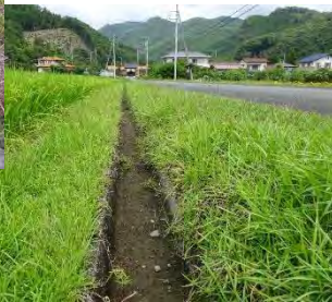
カバープラント施工後
