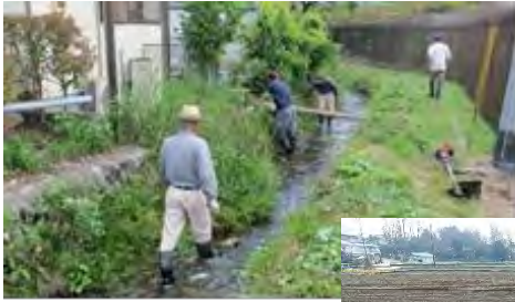
水路の草刈り作業
