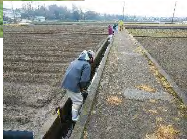
水路の泥上げ
