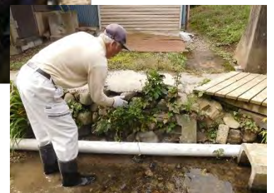
水路の補修風景
