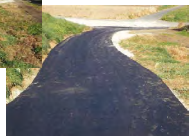
補修後の農道
