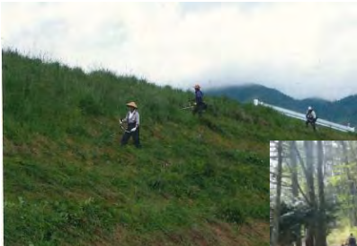
ため池堤体の草刈り
