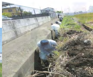
水路の泥上げ
