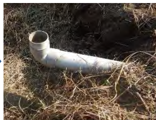
配管を上向きにして雨水を貯留
