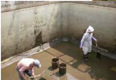
貯水槽の清掃風景
