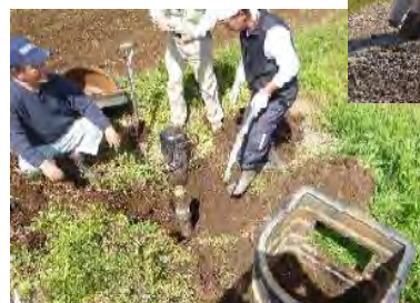
給水栓の補修
