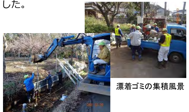
水路の補修風景
