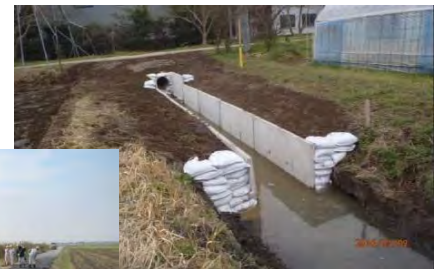
用排水路の補修
