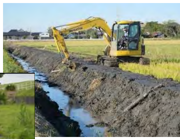
重機を活用した泥上げ
