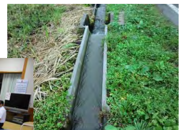
更新した水路
