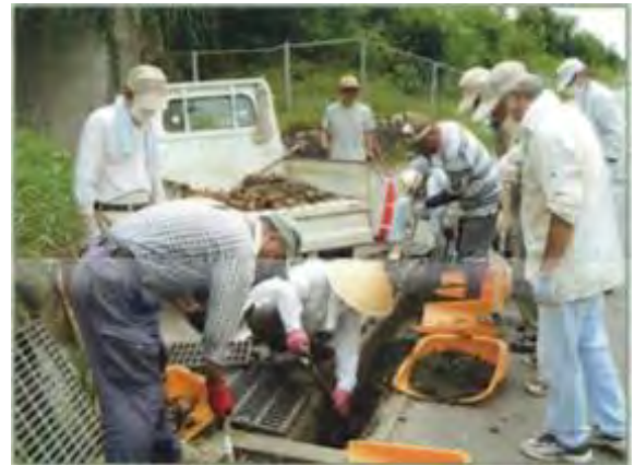
水路の泥上げ作業
