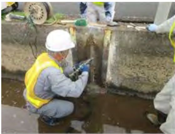
直営による水路補修
