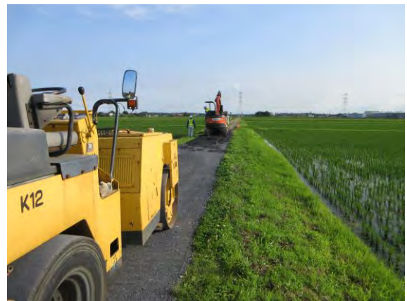
直営による農道舗装
