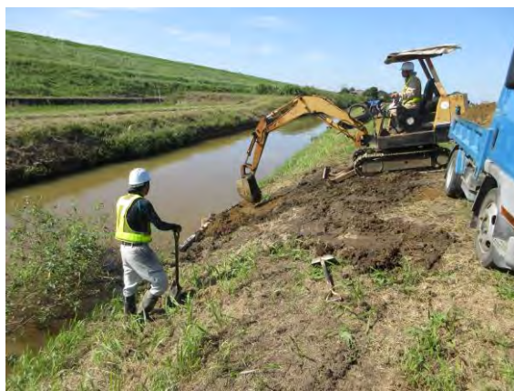
大型機械による泥上げ作業
