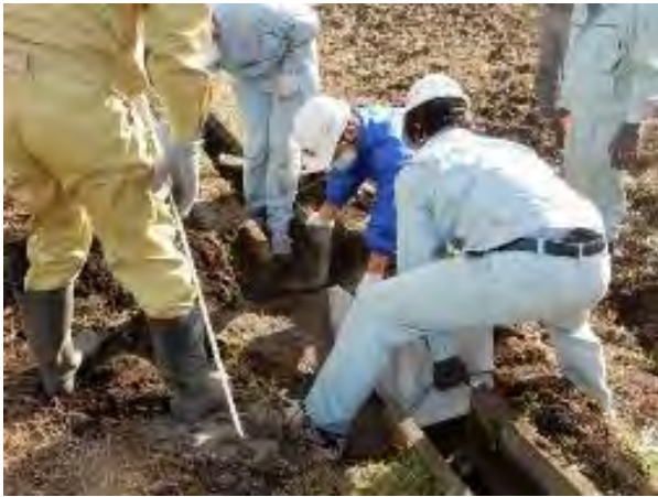
高校生による水路の補修
