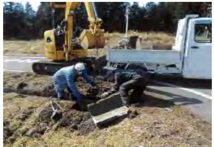
直営による水路補修
