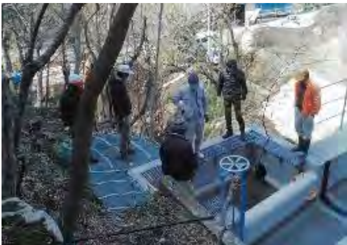
水路点検の様子
