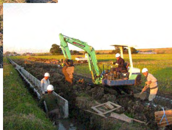
直営施工の様子
