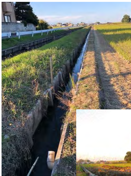
施工後の水路
