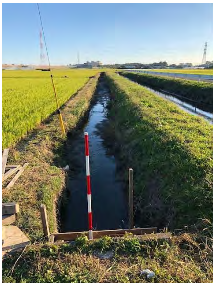
旧来から残る土水路
