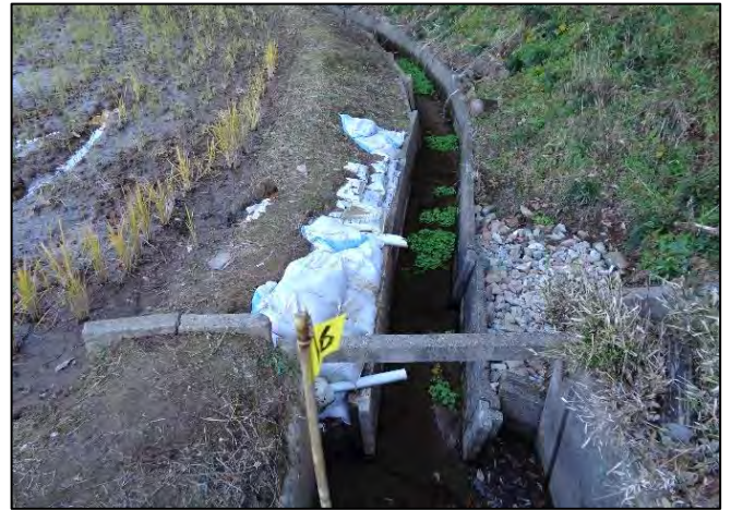
直営で設置した土留め
