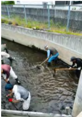
水路の泥上げ作業
