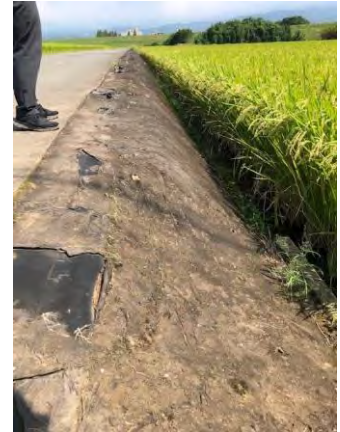
防草シートの設置
