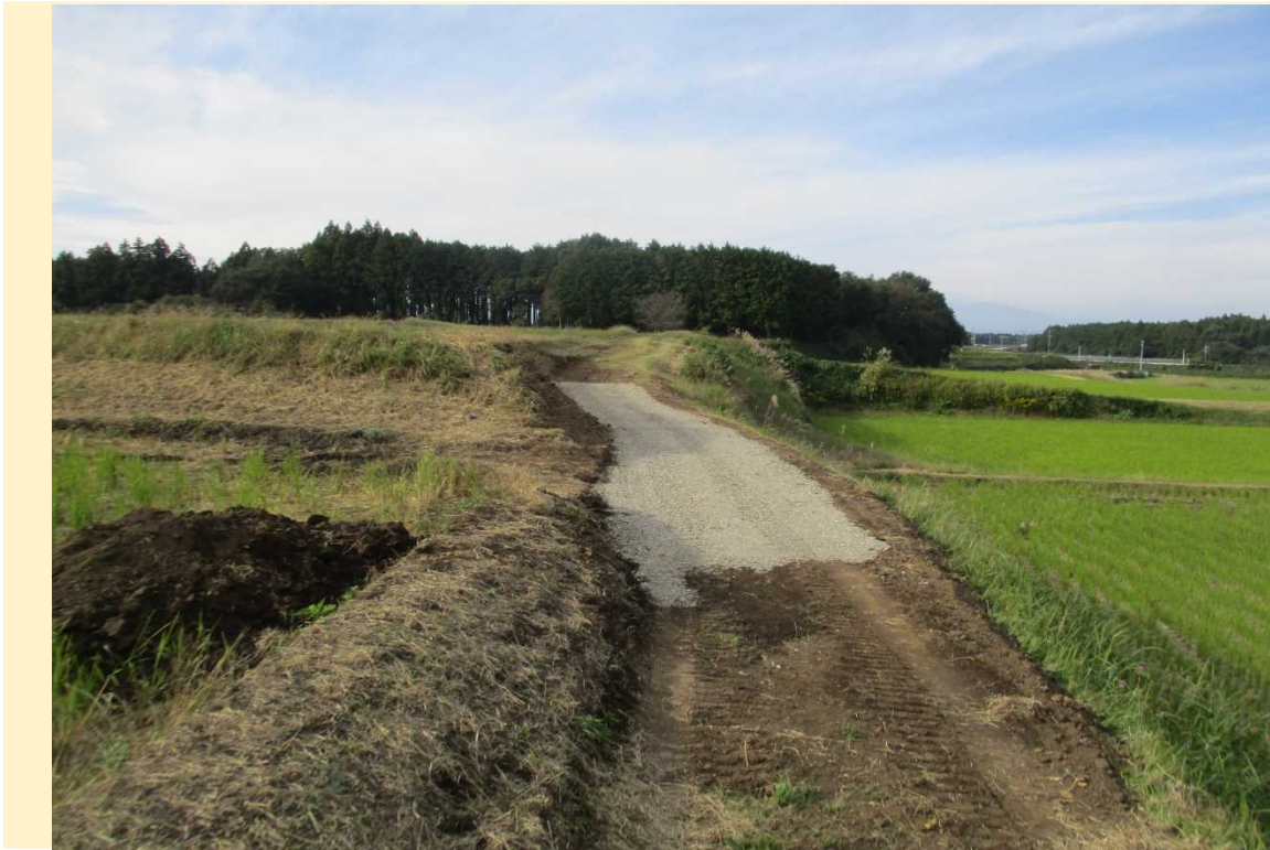
・施工完了状況①
