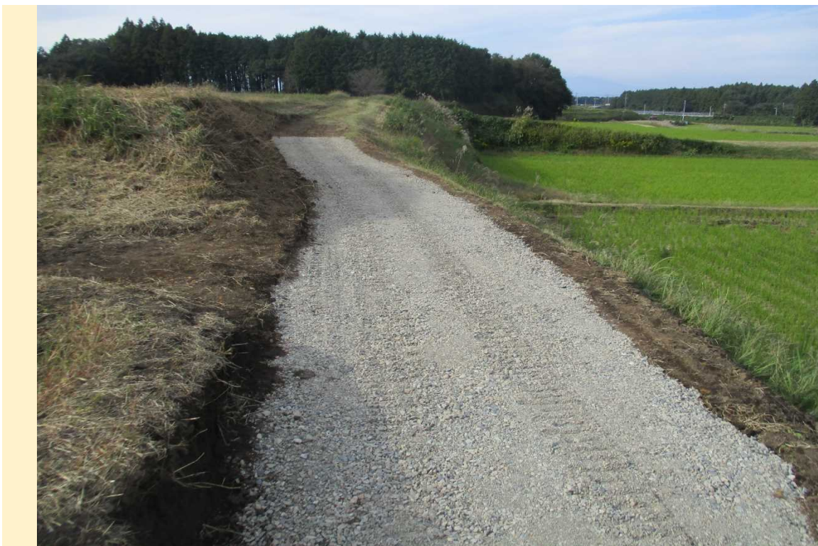
・施工完了状況②
