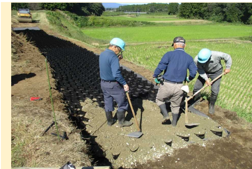
・砂利敷き均し状況
