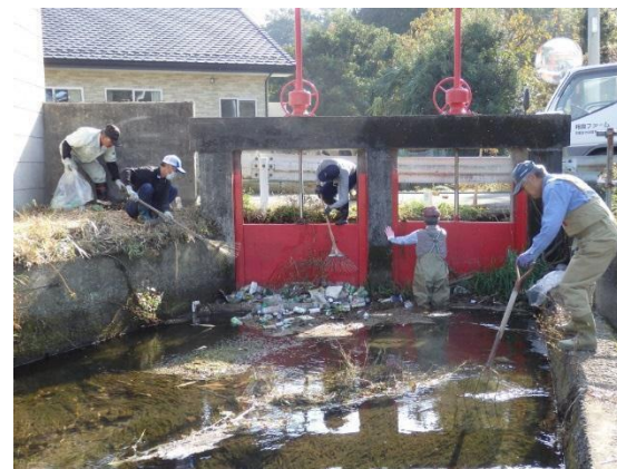
水門の清掃・点検
