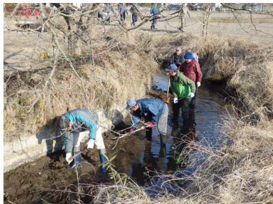
用水路の堀さらい
