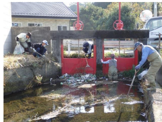
水門の清掃・点検
