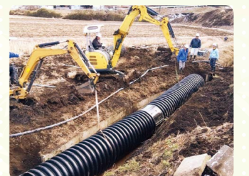
暗渠排水の更新
