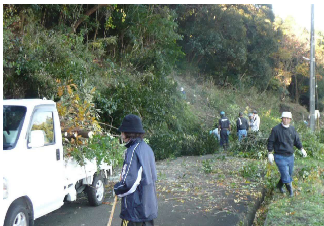
市道法面の支障木 伐採
